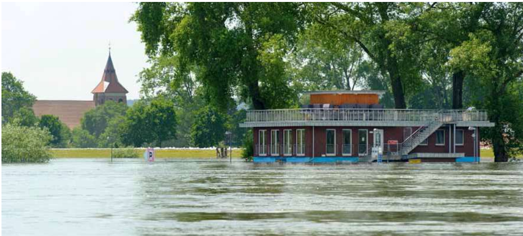
Blick von der Elbe auf das Bleckeder Fährhaus am 10. Juni 2013. Zwei Tage später ist ein historischer Höchststand erreicht. Für den Bürgermeister der Elbestadt bleibt der Hochwasserschutz eine wesentliche Aufgabe. Foto: A/t&w
